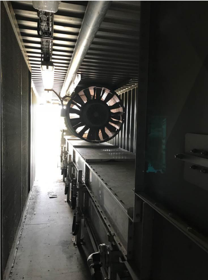
Bild 18: Blick vom hinteren Teil des Containers Richtung Tür
