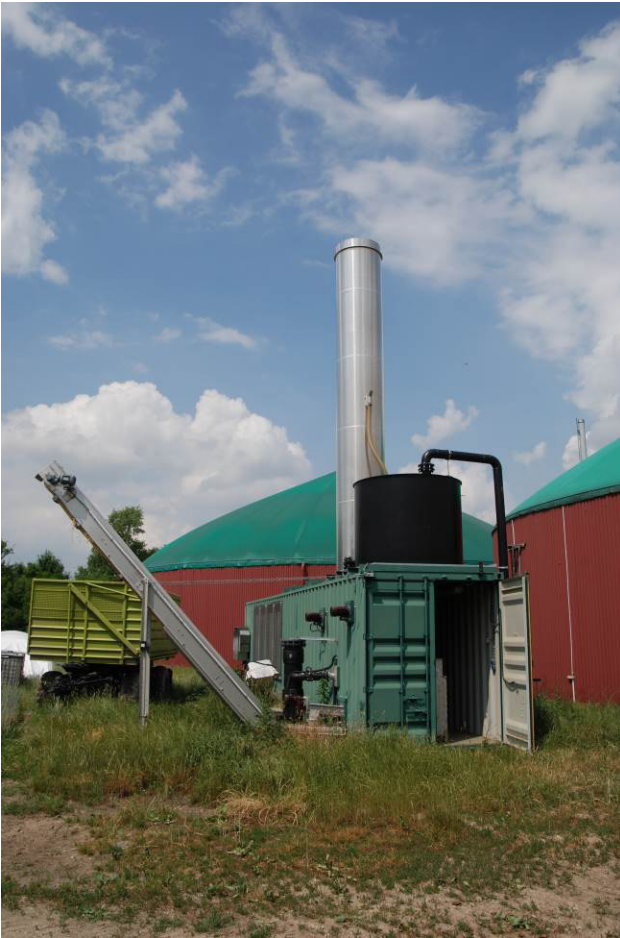
Bild 1: Bandrockner im Container mit geöffnetem Türenflügel. Oben befindet sich der Behälter für die Gärrestvorlage (schwarz) und der Abluftkamin. Auf der linken Seite befindet sich das Austragsband
