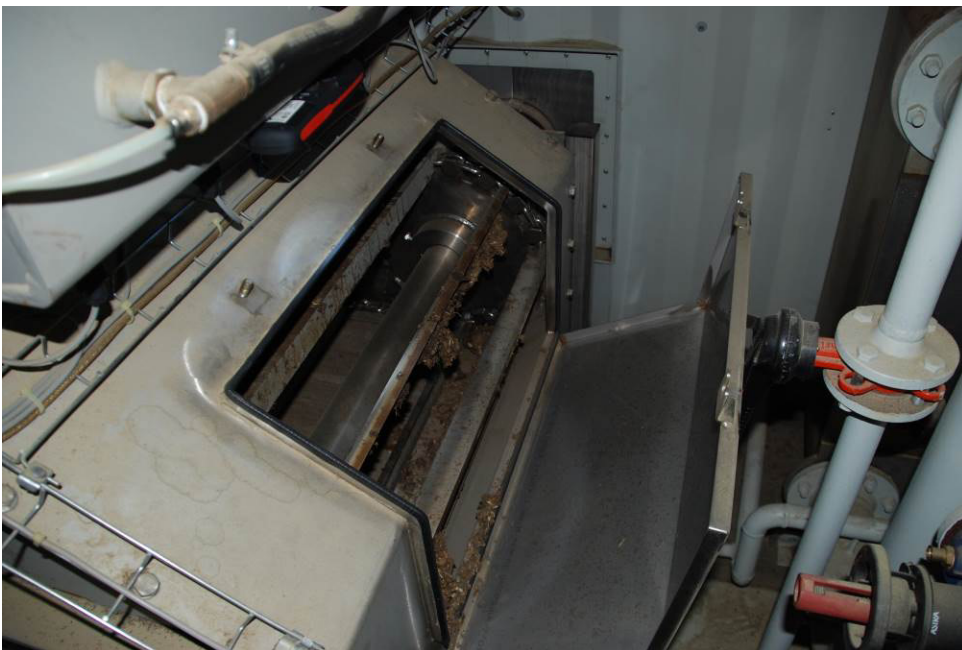
Bild 15: Revisionsöffnung (geöffnet) des Trogkettenförderers mit Resten von Trockengut
